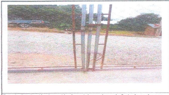
Foto 2: Sustitución de portón de metal con chapa de 5mts de ancho por 2.30 mts de alto.
